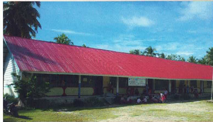
Frisch fertiggestelltes Schulgebäude nach umfangreicher Sanierung
