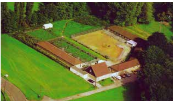
Wasserschäden und Feuchtigkeit haben dem alten Gebäude zugesetzt
