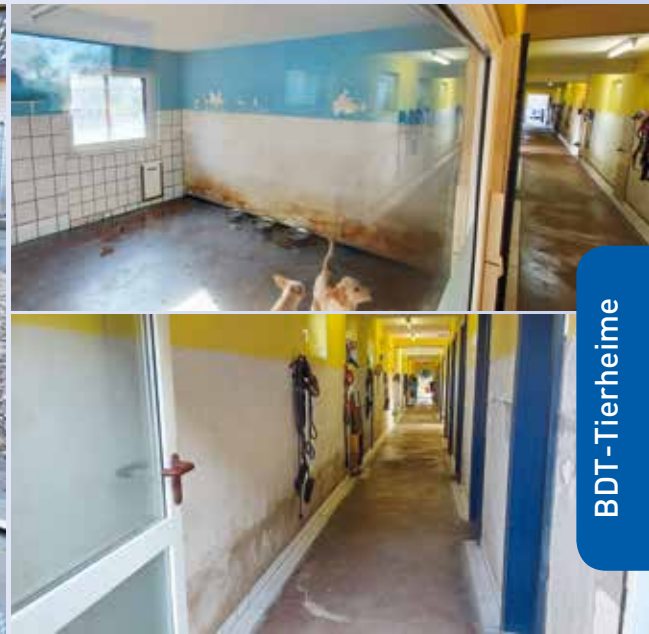
Wasserschäden und Feuchtigkeit haben dem alten Gebäude zugesetzt, und schwere Baumängel machen den teilweisen Neubau notwendig
