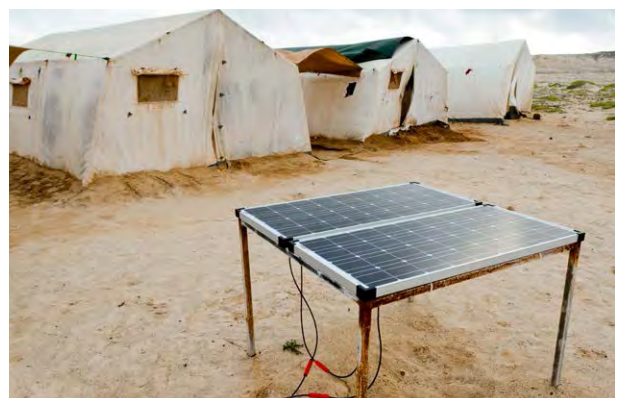
Eine der drei Solaranlagen, die für die Stromversorgung unserer Camps angeschafft wurden; hier im Camp Boa Esperança.
